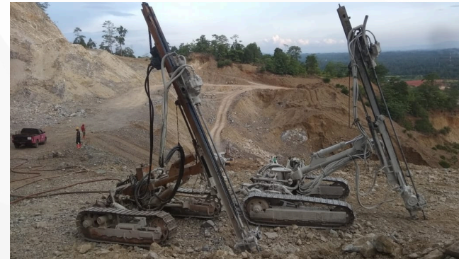
Pekerjaan Galian Batu Keras dengan Peledakan Terbuka Pembangunan Bendungan Ulu (Paket II)
