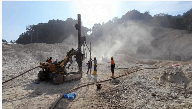
Pembangunan Bendungan Budong-Budong
