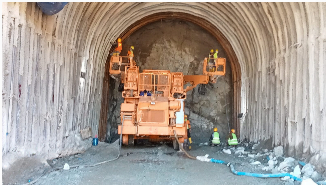
Pelaksanaan Pekerjaan Terowongan Pengelak dan Bangunan Pengambil pada Proyek Pembangunan Bendungan Bulango Ulu Paket-II (MYC)
