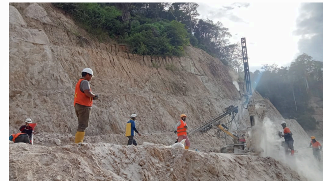
Pekerjaan Galian Batu Terbuka dengan Peledakan Proyek Pembangunan Bendungan Bulango Ulu Paket - I (MYC)
